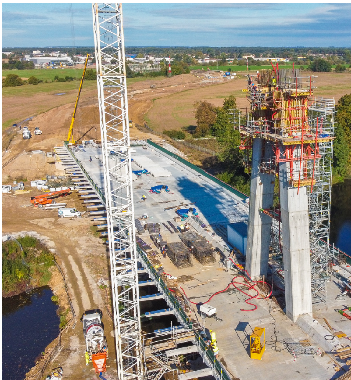
Stavba mostu je v plném proudu
