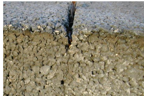
Obrázek 17. Provedení smršťovací spáry
