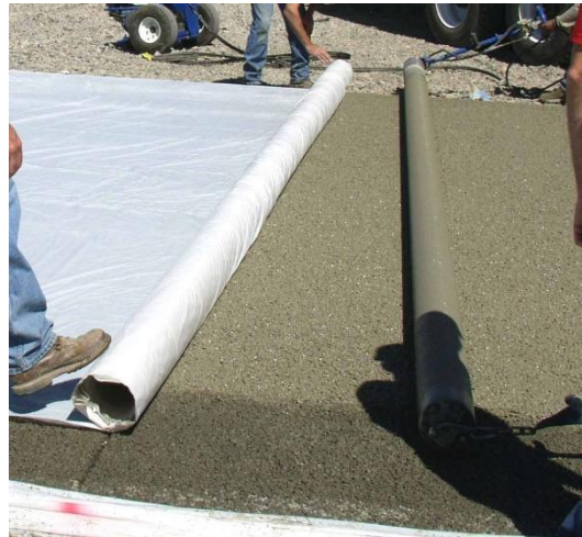
Obrázek 11. Ochrana pomocí plastové folie
