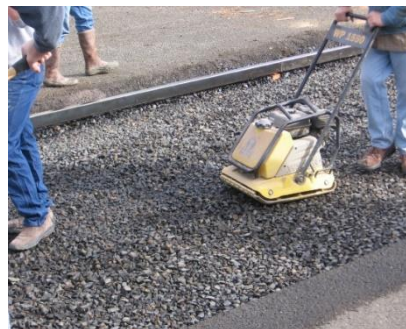
Obrázek 14. Hutnění podkladu
