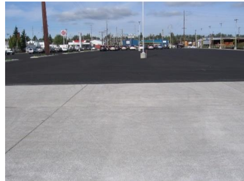
Obrázek 4. Světlý odstín betonu snižuje absorpci slunečního záření
