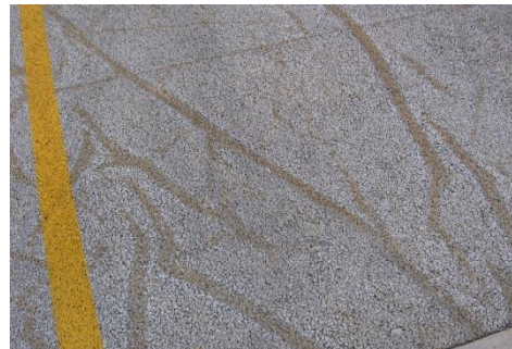
Obrázek 18. Přirozené zbarvení povrchu způsobené kondenzací vlhkosti pod folii
