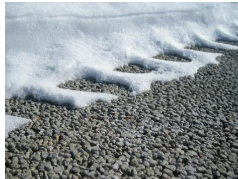
Obrázek 5. Betony Pervia vynikají vysokou mrazuvzdorností
