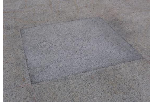
Obrázek 20. Lokální provedení opravy poškozené plochy
