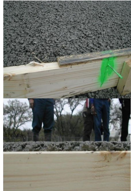
Obrázek 15. Navýšení tloušťky vrstvy betonu před hutněním
