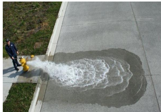
Obrázek 1. Beton PERVIA umožňuje díky vysoké odpropustnosti zachovat přirozené vlhkostní charakteristiky krajiny.
