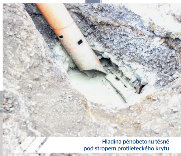
Dokonalé obtečení ocelových hajčmanů a zatečení až po zával
