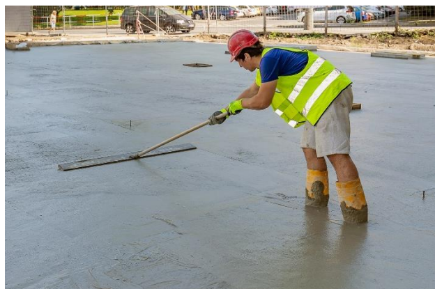
Urovnání povrchu POROFLOW pomocí latě na tyči
