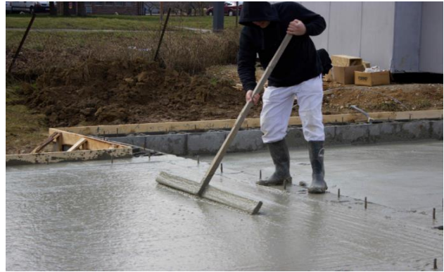
Vytvoření stabilního podloží pod RD
