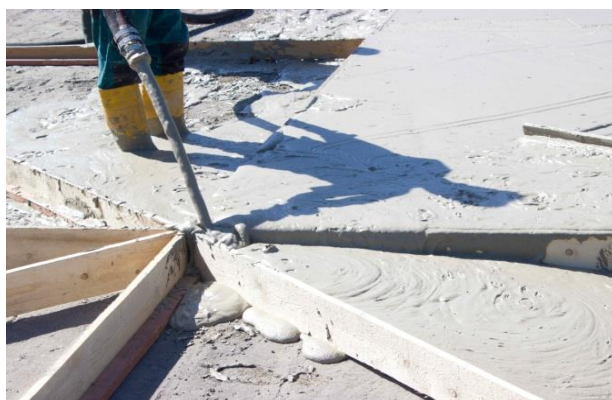
Dřevěné bednění pro násobné spády
