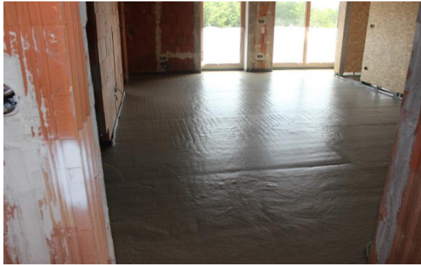
Izolace a vyrovnání podlahy (rozvody, nerovnosti)
