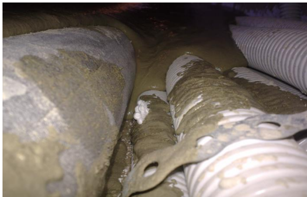
Dokonalé obtékání rozvodů v podlaze
