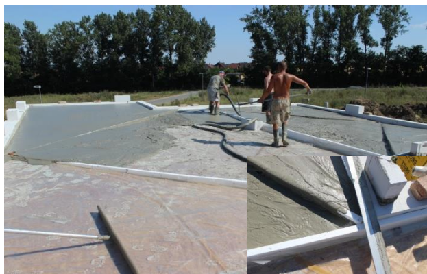
Provádění násobných spádů
