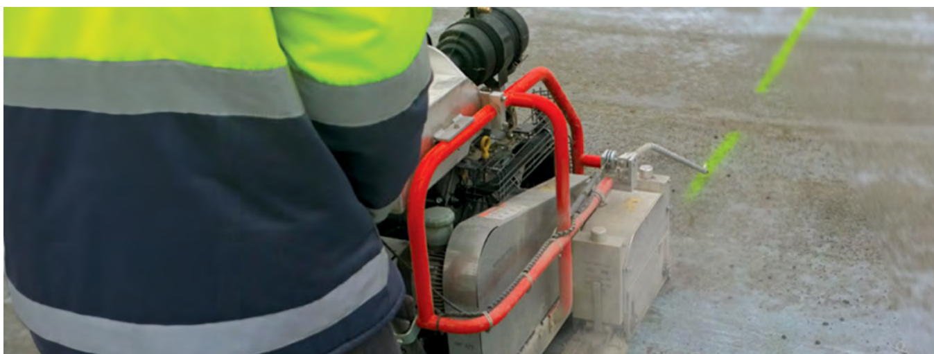
Provádění dilatací.
