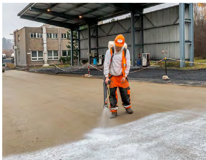
Ošetření zajišťující řádné vyžrání cementového pojiva.
