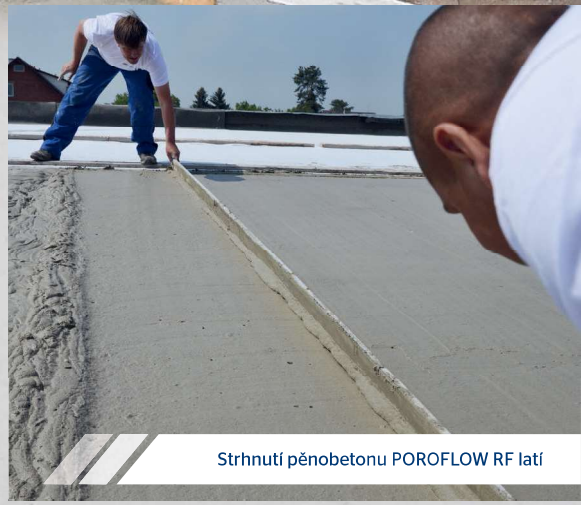
Zpracování POROFLOW RF pomocí natřávací tyče
