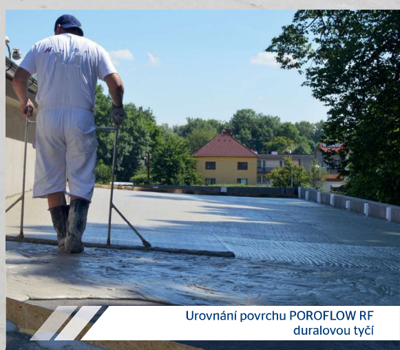
Strhnutí pěnobetonu POROFLOW RF lať
