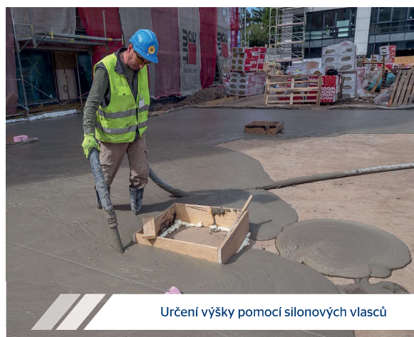
Polystyrenové bednění pro POROFLOW RF
