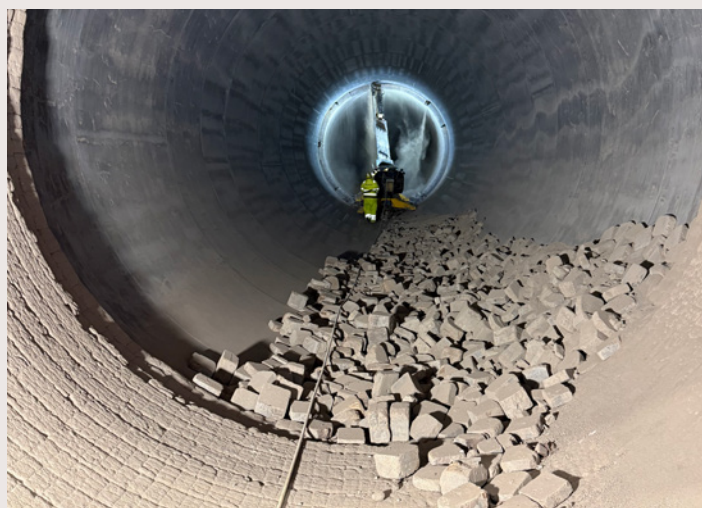
Obnova žáruvzdorné vyzdívky rotační pece
