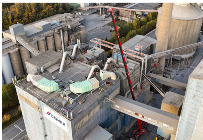
Instalace akustických tlumičů na střechu mlýnice pomocí jeřábu, pohled na areál cementárny a obec Prachovice
