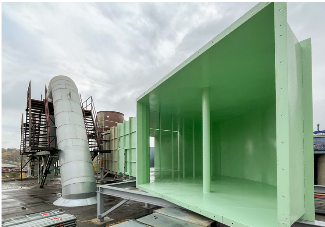
Montáž tlumiče hluku na cementové mlýnici
