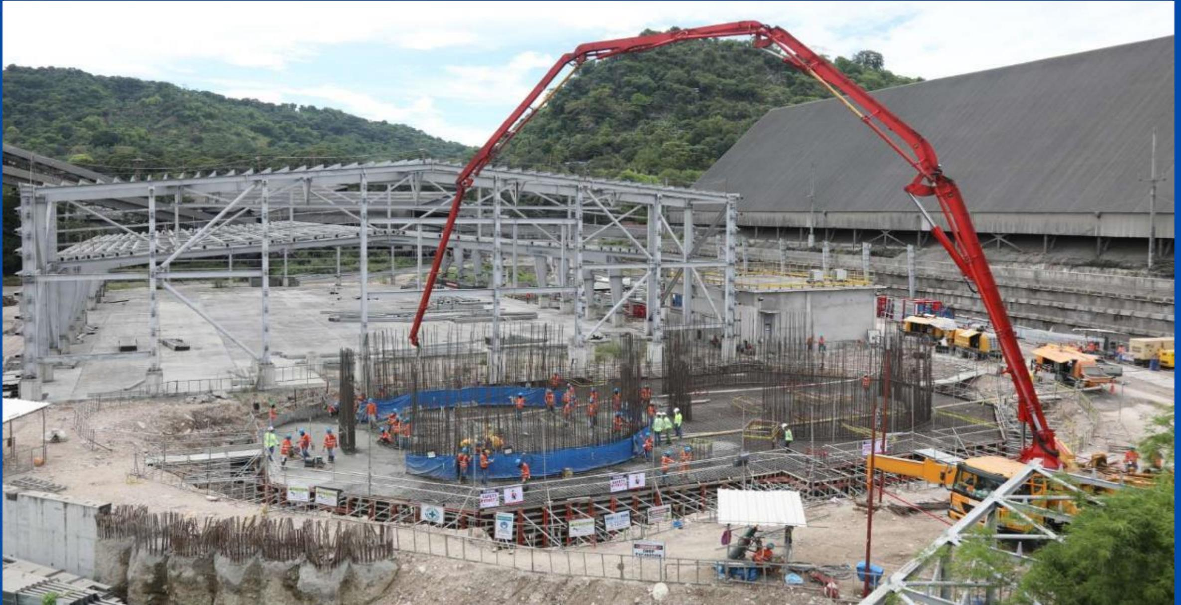
Vaciado de cimientos de concreto para los silos de cemento en la nueva línea de la planta Solid
