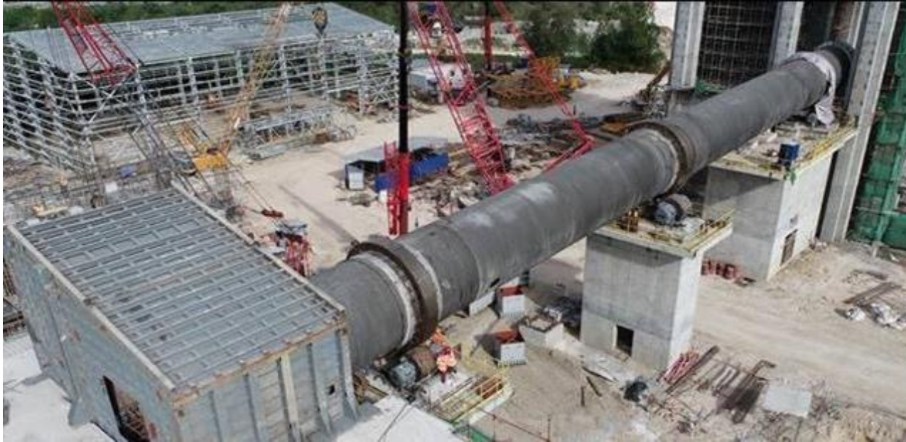
Levantamiento a posición del nuevo horno en la Planta de Cemento Solid (Ene. 2021)
