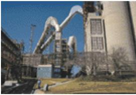
*Con el secador de puzolana de planta Guadalajara, México, se dio un ejemplo de ecoeficiencia en el que existe un beneficio ecológico y económico, al aprovechar el calor residual de los gases de proceso para secar materias primas. La innovación tecnológica Cemex de este secador, está dando ahorros del orden de 12.4% en energía térmica y de 4.5% en energía eléctrica.*
